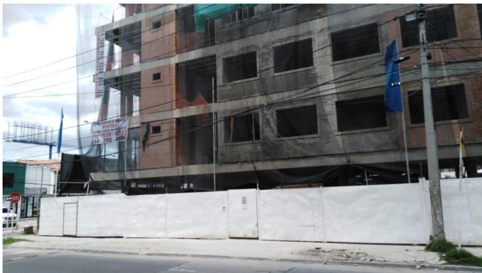
Figura 26. Edificio en construcción, Bogotá, (Fuente propia, 2019)
