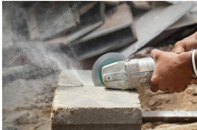
Figura 28. Detalle corte de ladrillo, (Deposiphotos, 2014)
