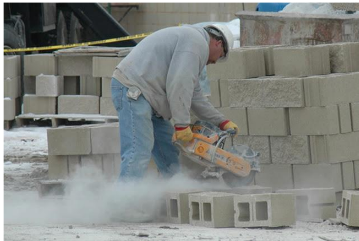
Figura 18. Exposición de trabajadores al polvo producido por la construcción, (Seguridad y Salud Puerto Rico, 2018)
