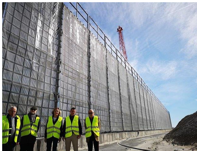
Figura 24. Sistemas antipolvo en el muelle de graneles sólidos, (Europa Press, 2019)
