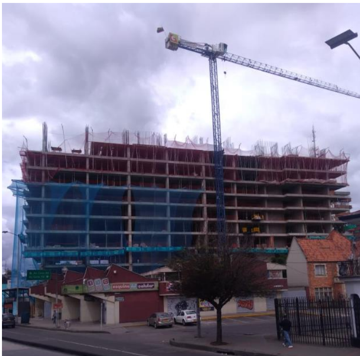
Figura 29. Edificio en construcción, Bogotá, (Fuente propia, 2019)
