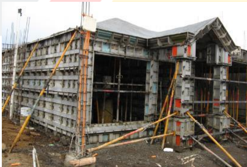
Figura 53. Encofrado vertical. Fuente Argos.
