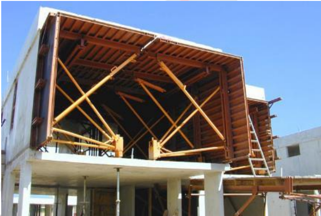
Figura 54. Encofrado túnel Fuente Argos.
