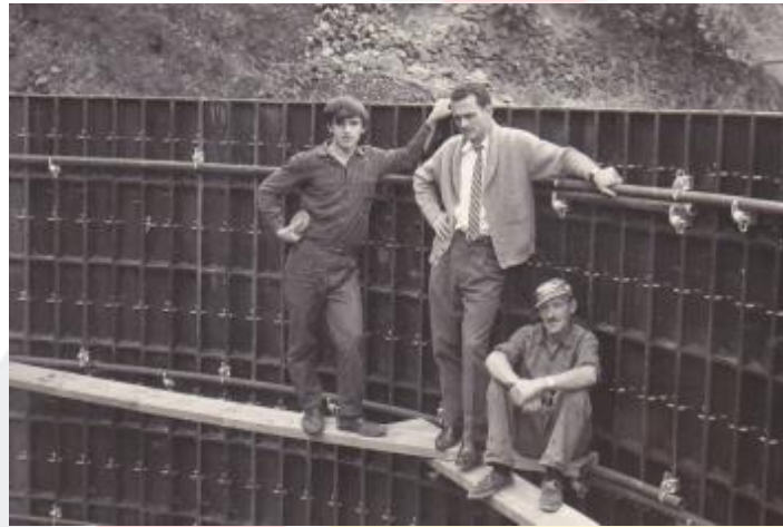
Figura 52. Encofrado horizontal. Fuente edilsider.com.
