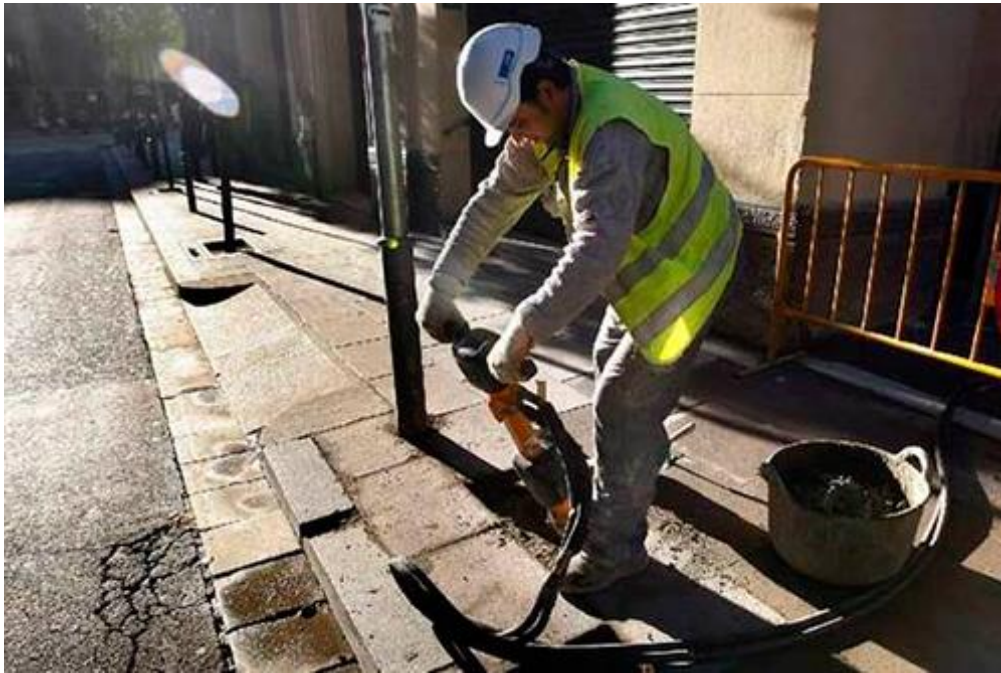
Ilustración 54 Ruido generado por actividades de construcción en espacio público. (Ramirez, 2019)
