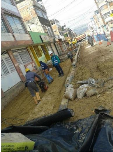
*Imagen 75, Instalación del geotextil. Fuente: Cartilla guía para la elaboración de andenes en pavimento articulado 2019*
