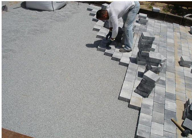
*Imagen 76, Vertimiento de grava. Fuente: Cartilla guía para la elaboración de andenes en pavimento articulado 2019*
