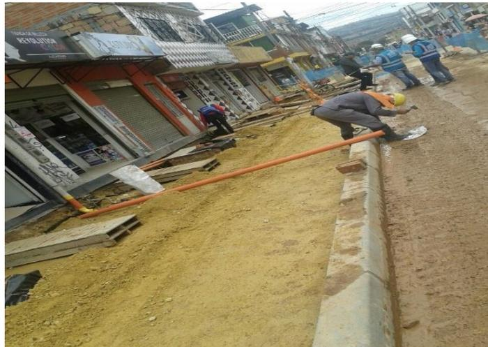
*Imagen 74, Nivelación y compactación. Fuente: Cartilla guía para la elaboración de andenes en pavimento articulado 2019*
