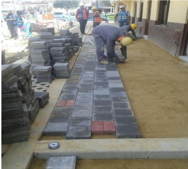
*Imagen 77, Colocación de adoquines. Fuente: Cartilla guía para la elaboración de andenes en pavimento articulado 2019*
