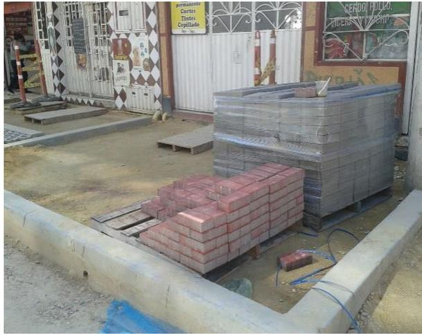
*Imagen 71, Acopio de adoquín. Fuente: Cartilla guía para la elaboración de andenes en pavimento articulado 2019*
