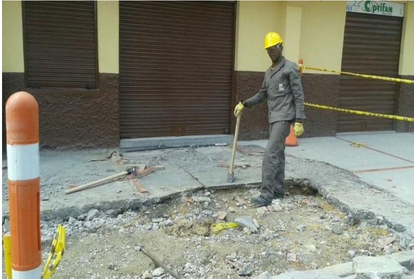
*Imagen 73, Demolición de superficies. Fuente: Cartilla guía para la elaboración de andenes en pavimento articulado 2019*
