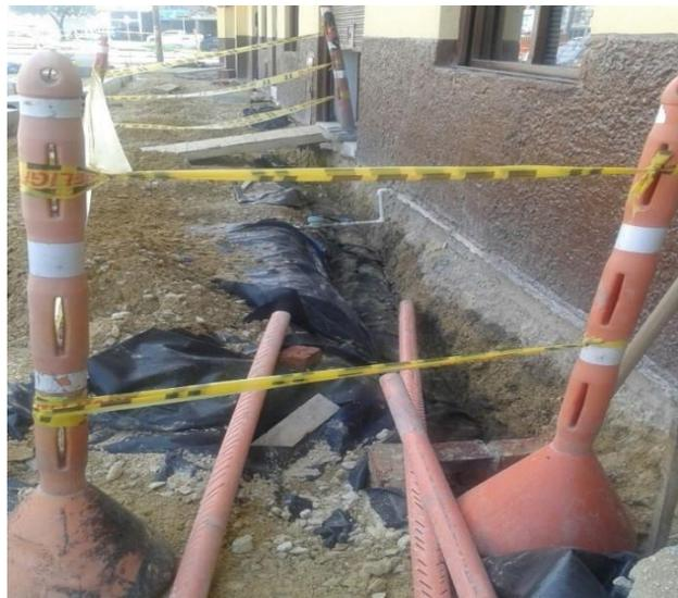
*Imagen 72, Cerramiento de obra. Fuente: Cartilla guía para la elaboración de andenes en pavimento articulado 2019*
