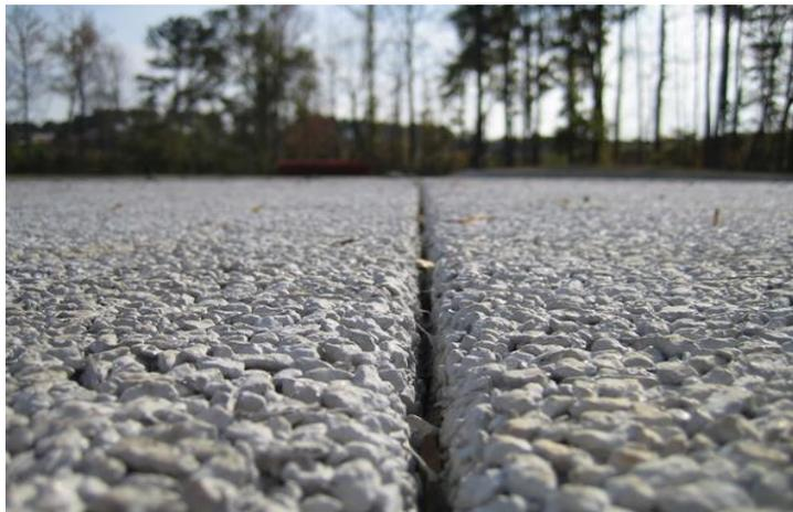
Imagen 38, Concreto reciclado Fuente: <https://www.360enconcreto.com> 2017
