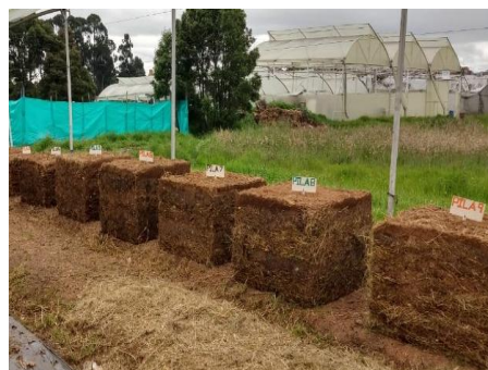
Ilustración 8: pilas terminadas y marcadas
