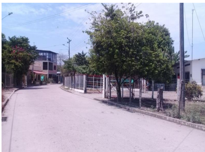
Figura 93 Pavimentación de la vía La Chamba – Espinal. Fotografía tomada por: A. Catalina Ortiz Díaz
