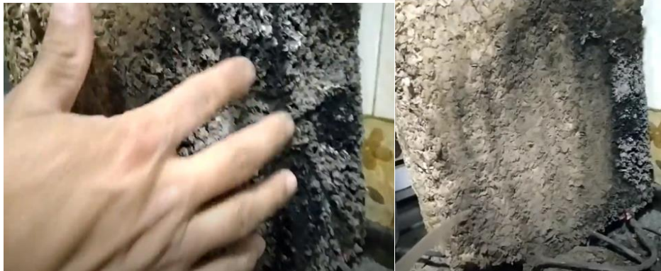
Figura 51. Retiro de la capa carbonizada, espesor aprox de 3mm
