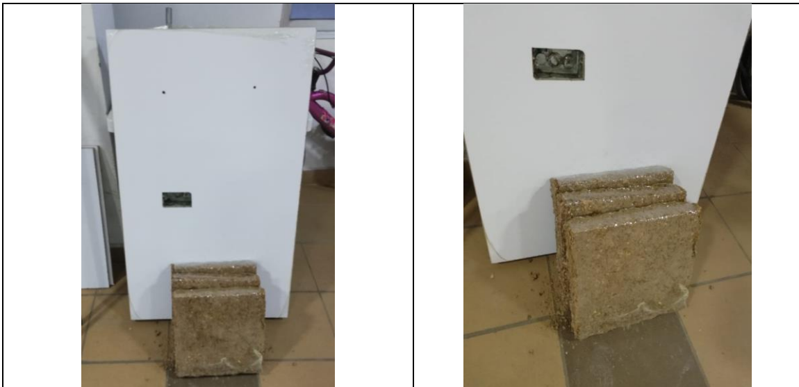
Alistado e instalación del acabado en el panel
