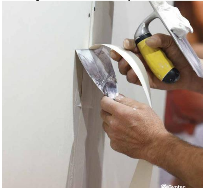
Figura 57. Tratamiento de juntas
