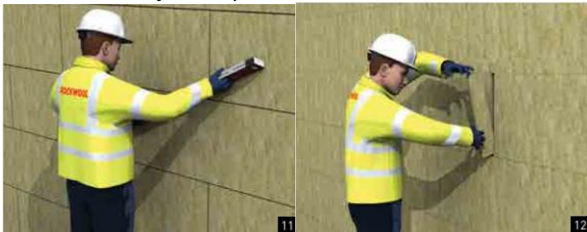
Figura 55. Fijacion de Paneles Poliestex
