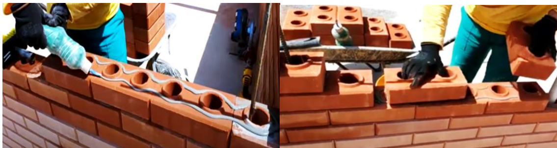
Figura 52. Instalación y proceso de pega de Ladrillo Modular Ecológico
