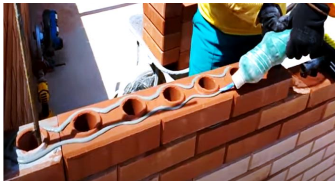
Figura 4. Instalación y proceso de pega
