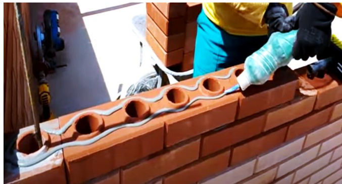
Figura 137. Instalación y proceso de pega
