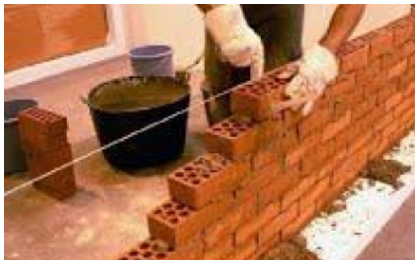
Figura 76. Mampostería no reforzada
