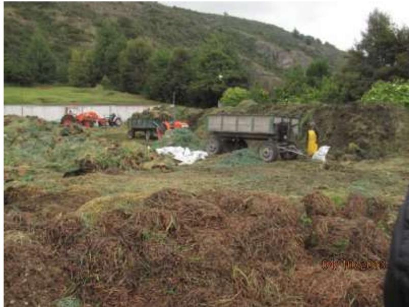
según un cronograma de semanas se va reubicando aquí abajo donde se arman las pilas, se pican y mueven cada ocho días. Todo el lixiviado que se produce en este proceso se recoge en estas canales que ven y se lleva a ese tanque en donde se revisan las condiciones de pH y se vuelve a bombear al proceso de compostaje, es decir que no hay vertimientos todo vuelve a entrar al proceso. . Una vez el compostaje está listo entra a ser parte del sustrato de las camas en cultivo.
