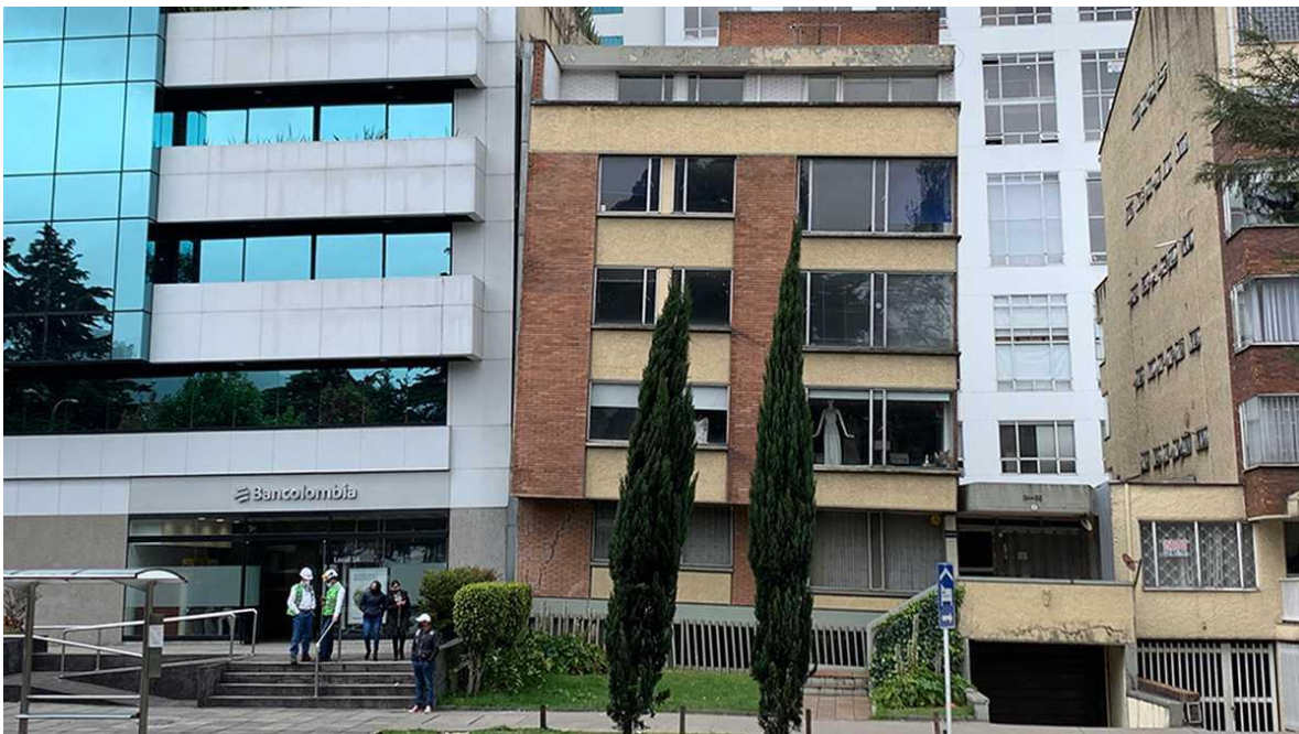
Edificio Av. Calle 100 en la ciudad de Bogotá, presenta fisuras en su estructura por hundimiento de la cimentación.
