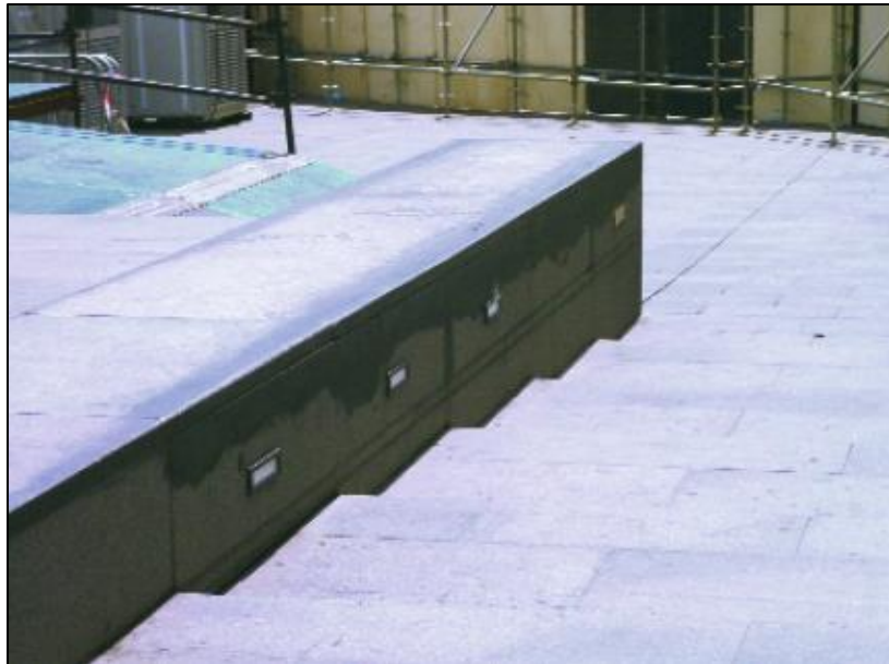
Esquema de una alteración extrínseca humana por ejercicio de “skaters”, porosidad por fricción aumentando la humedad
