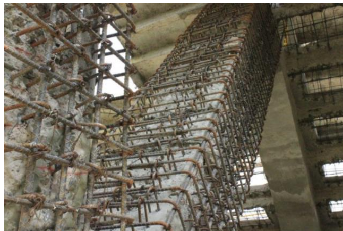
Refuerzo de una estructura en concreto por técnica de revestimiento en concreto.
