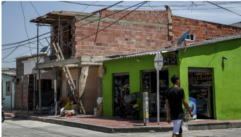
Figura 19. Construcción empírica sin licencias de construcción.
