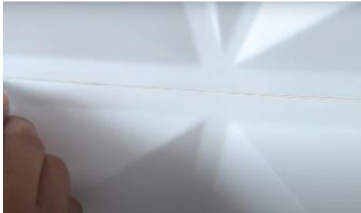
Figura 84 Rellenado de juntas entre paneles
