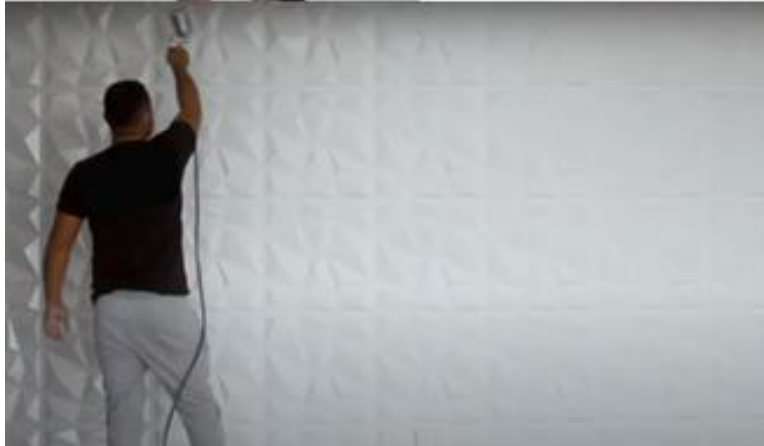
Figura 86 Aplicación de pintura en los paneles
