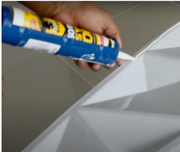
Figura 82 Aplicación de silicona al panel
