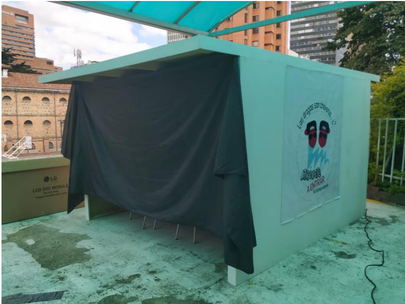
Figura 32. Construcción de la estructura del cine Fuente: Elaboración propia.
