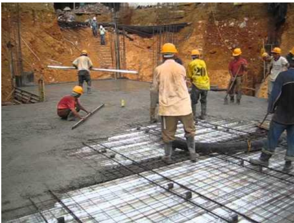
Ilustración 37 Colocación del concreto
