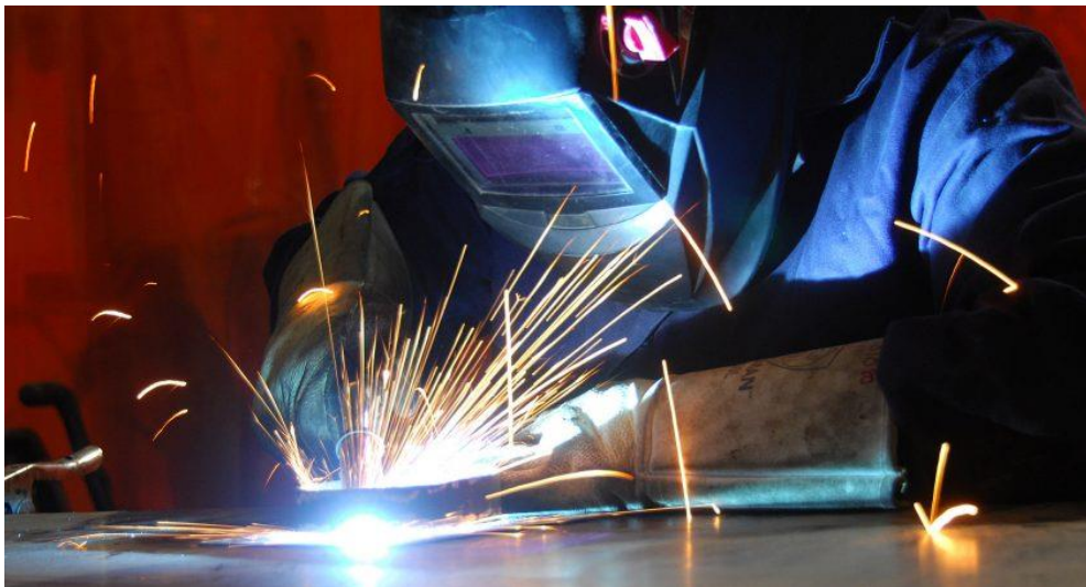
Ilustración 22 Operario de soldador
