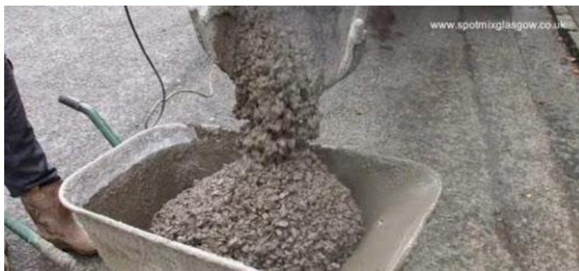
Ilustración 36 Descargue de material del equipo mezclador
