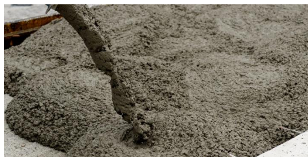
Ilustración 11 Concreto en estado fresco
