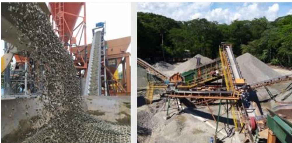
Fig. 29 Planta de concretos INGEKAR LPR S.A.S
