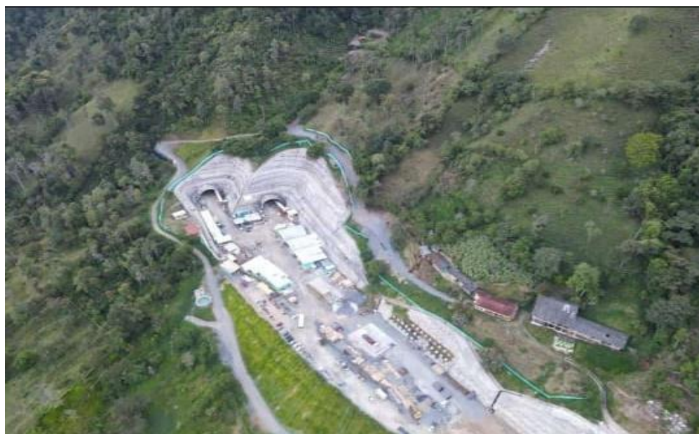
Fig. 28 Proyecto Túnel Amagá Antioquia
