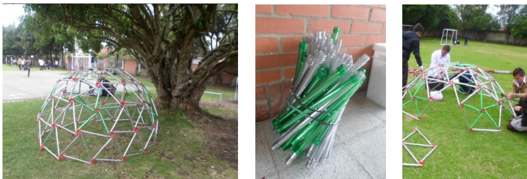
Ilustración 34 Proceso constructivo de domo geodésico con botellas PET, tomado del blog de investigación y diseño con materiales reciclados.
