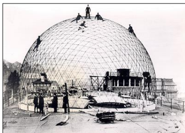
Domo en construcción
