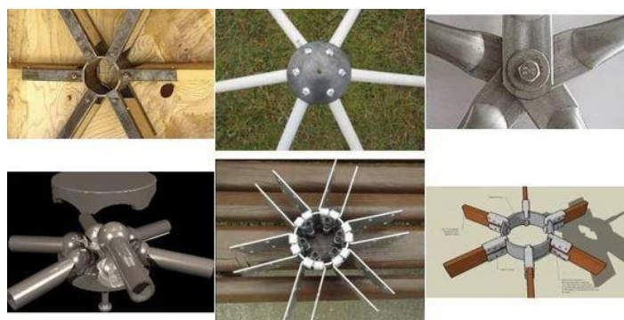
Ilustración 37 nodos para construcción de un domo, tomado de página oficial de la cadena de periodismo Ovacen,( publicación: como hacer un domo)
