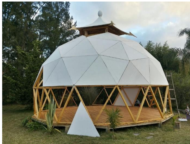
Ilustración 39 paneles de los domos tomados de la página oficial Santafé domos de la publicación: tipos de cubiertas para domos 16 de junio de 2019.
