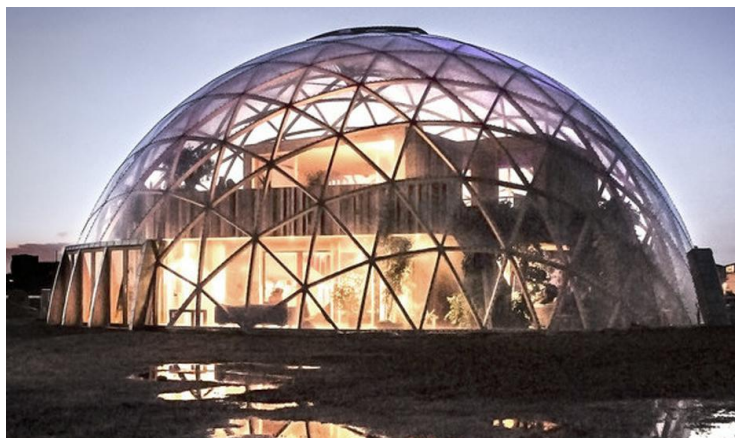
Ilustración 48 inmenso domo en el predio del ex zoológico municipal San Francisco de Asís, tomado de periódico el liberal (liberal, 2019).
