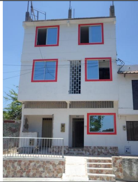
Hotel el Terminal en construcción Fotografía tomada por: Katherine Matiz
