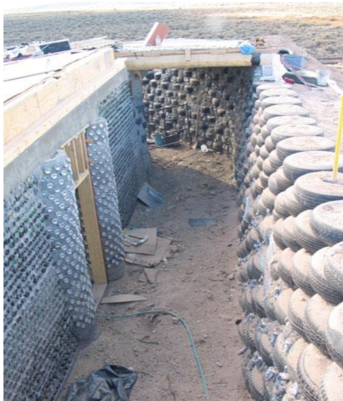
Figura 30 muro en llantas Earthship obtenido de (Querceto, 2010)
