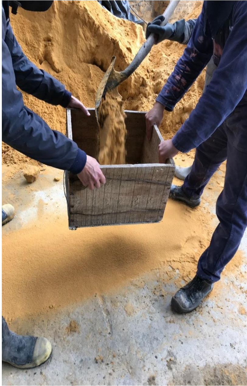
Figura 49 Tamizaje de áridos, fuente propia 2021.
