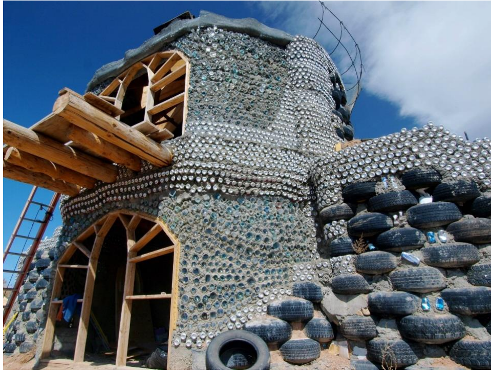
Figura 29 casa Earthship (Nave terrestre). El diseño de Reynolds, viviendas construidas con llantas usadas México obtenida de (Ecohabitar, 2019)
