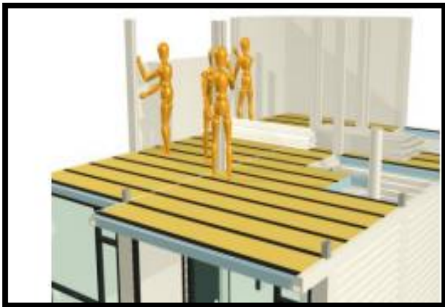
Figura 32. Instalación de paneles. Fuente. Gómez Mahecha.2020
