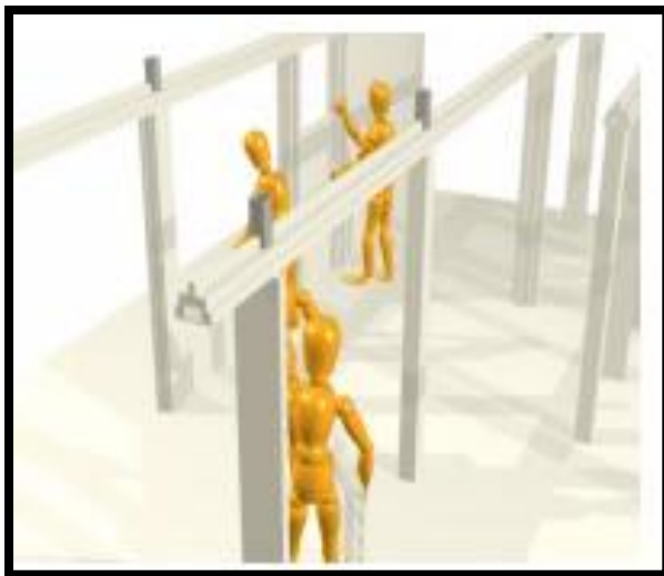
Figura 29. Instalación de rieles para puertas y ventanas. Fuente. Gómez Mahecha.2020
