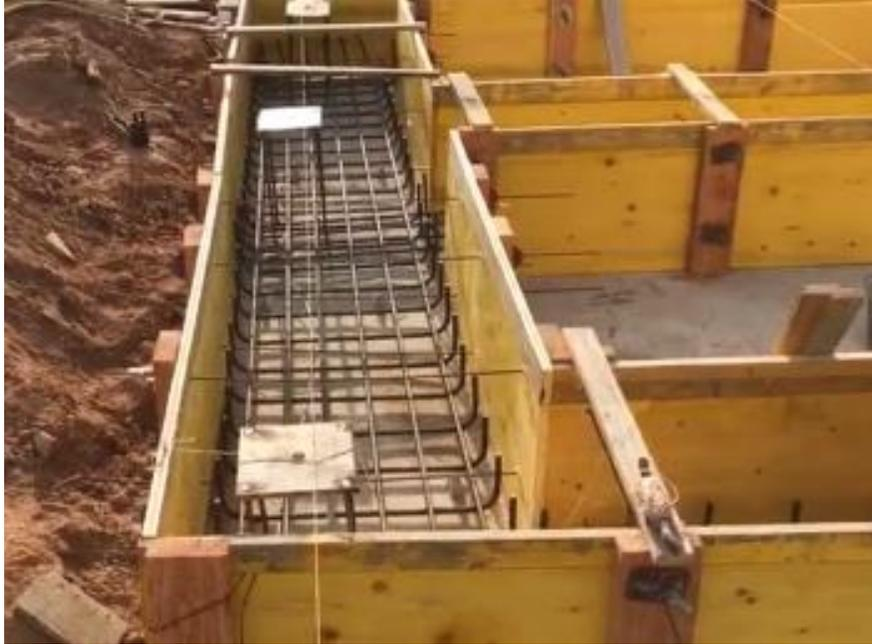
Figura 55. Armado zapata corrida con placa de anclaje. Mojuru Modular Building. 2017.
