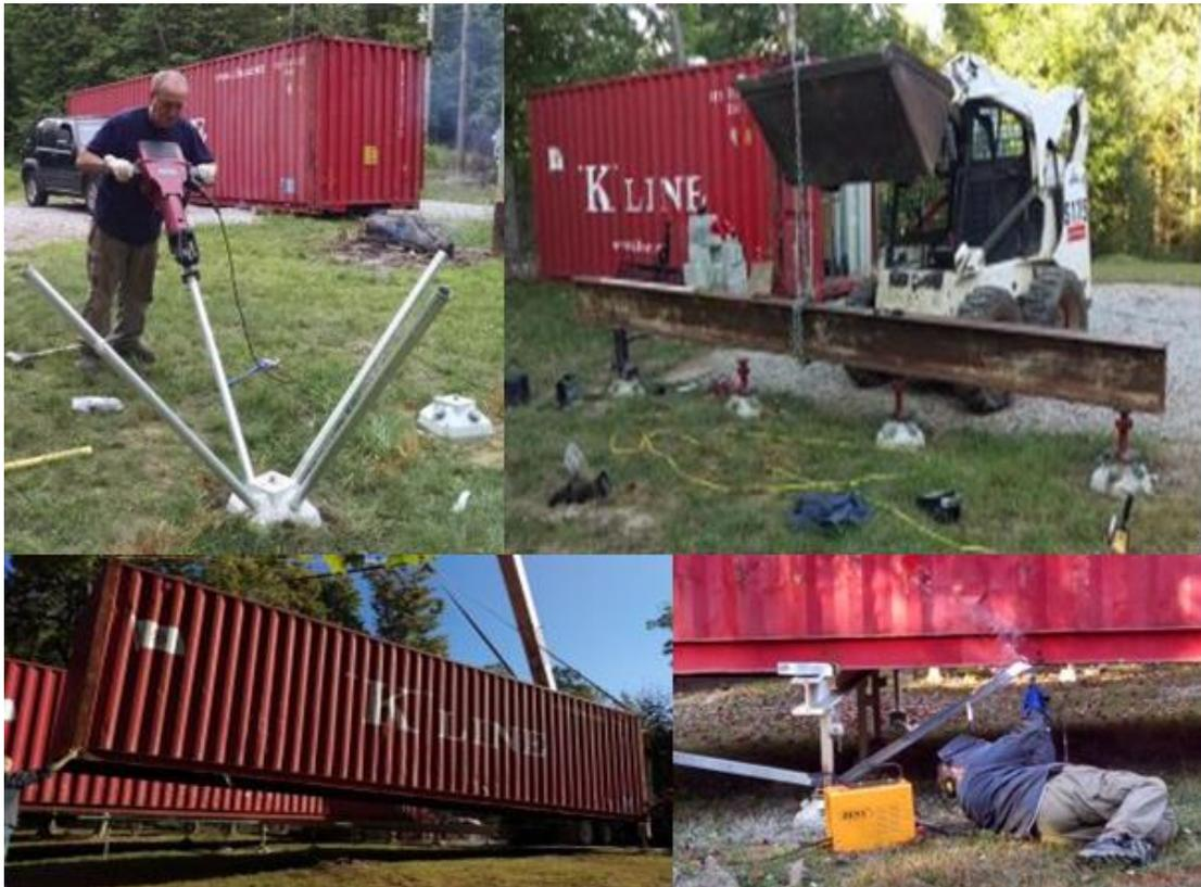
Figura 71. Collage proceso de construcción cimentación contenedores. Discover Containers. 2019.
