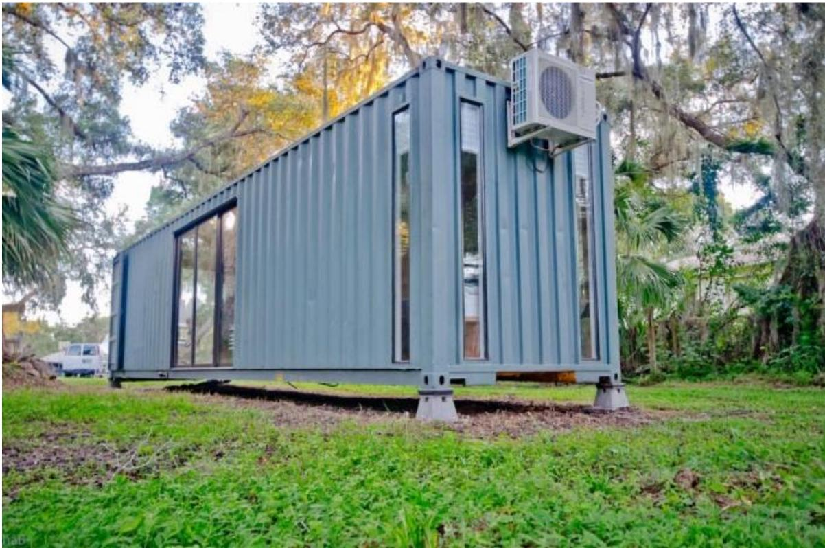
Figura 66. Cimentación con pedestal en construcción con contenedor. Ryan. 2017.
