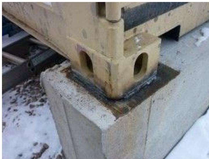
Figura 28. Unión permanente de contenedores con soldadura. Habilísimo. 2021
