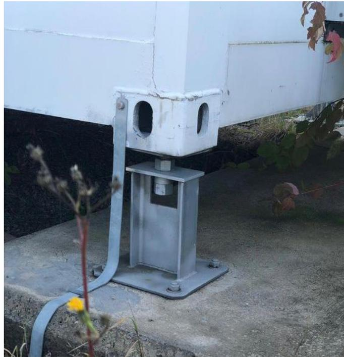
Figura 27. Sujeción mecánica atornillada para contenedores en edificaciones. Decor8.2021
