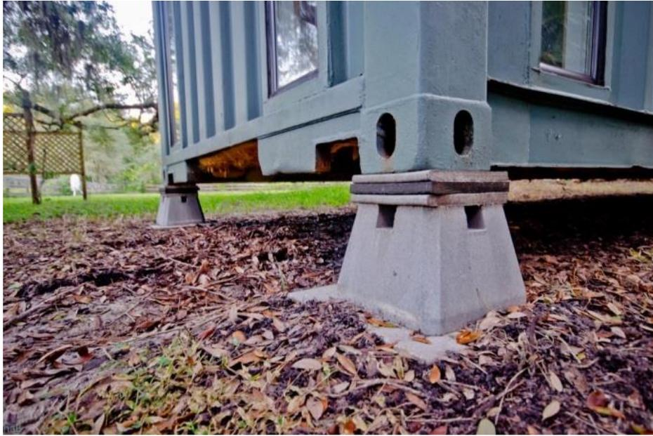
Figura 67. Cimentación con pedestal en construcción con contenedor. Ryan. 2017.
