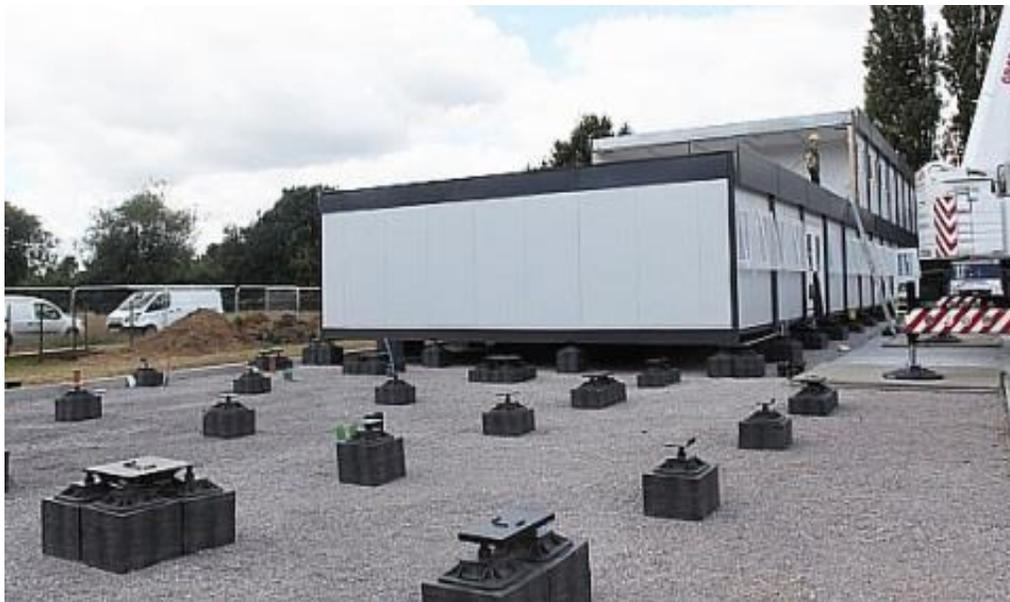
Figura 62. Base o cimiento portátil con contenedores. Ingeniería & Construcción S.A.S. 2021.
