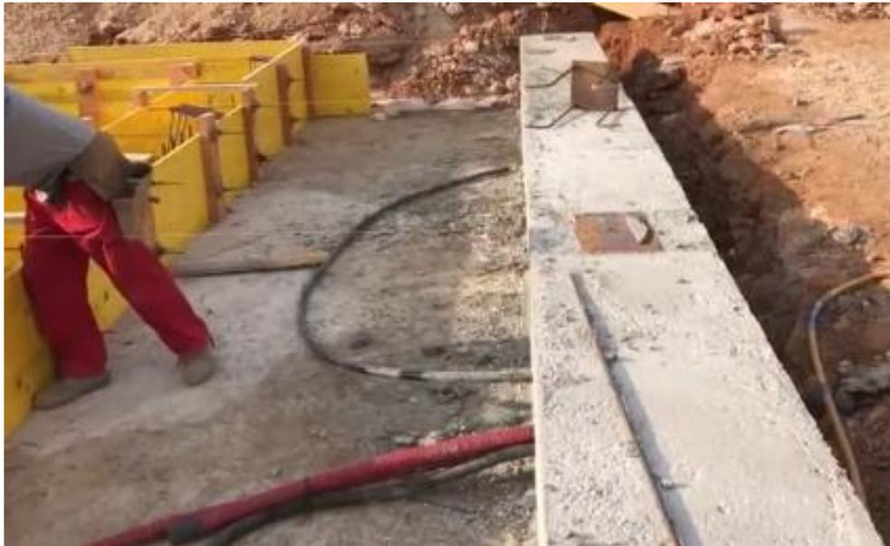
Figura 56. Zapata corrida fundida con planas de amarre. Mojuru Modular Building. 2017.
