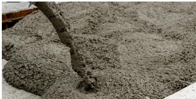
Ilustración 11. Concreto en estado fresco
