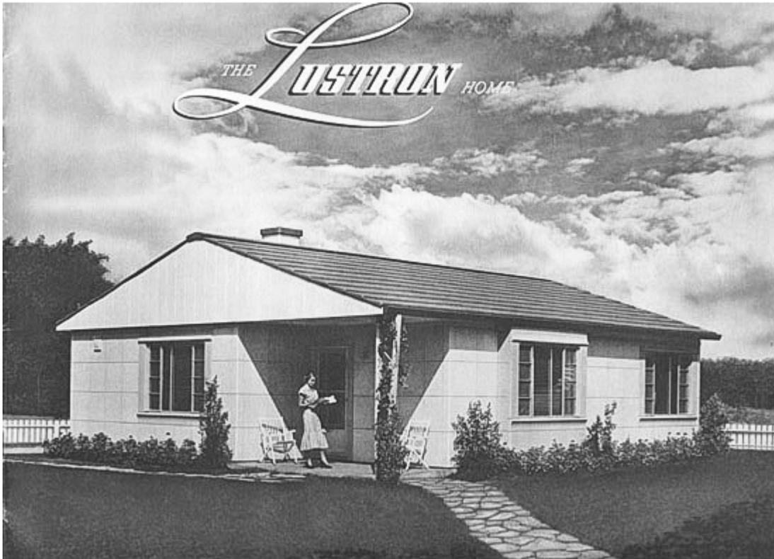
El tipo de casa prefabricada descrito aquí es lo que actualmente identificamos como modular o manufacturada. En el caso de las casas modulares prefabricadas, los módulos individuales o las secciones de la estructura se construyen fuera de las ubicaciones de ensamblaje para ser transportados y ensamblados en cuestión de días, listos para ser habitados. Algunas de estas viviendas han perdurado hasta nuestros días.
