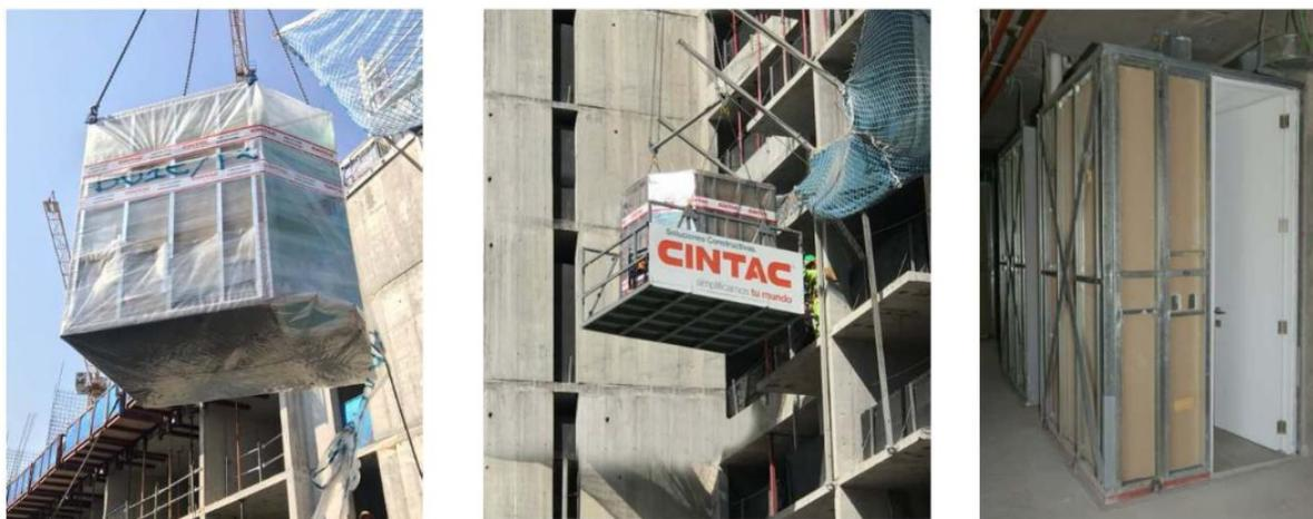
**Producto:** Módulo de baño prefabricado a medida por Hydrodiseño, España. baños a medida prefabricados, completamente acabados, con las instalaciones eléctricas, de fontanería y de ventilación listas para ser conectadas a la red general de la edificación. Las tuberías de fontanería son de polietileno reticulado (PE-Xa), mientras que las de desagüe, embutidas en el suelo o paredes, están fabricadas en HDPE. Cada sanitario cuenta con su propio sifón. Todas las
