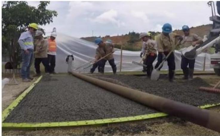
*Figura 49. Extendido y compactación del concreto permeable. Fuente: Argos. (2022)*
