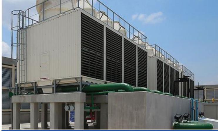
Figura 6. Sistema de rechazo de calor
