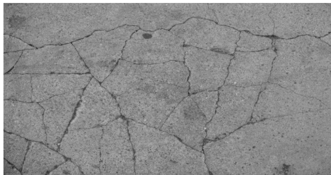
Ilustración 13. Retracción en el concreto
